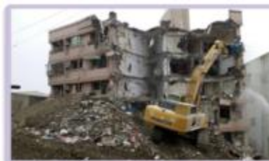
歸仁區幸福大樓拆除
