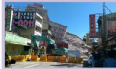
新化區京城銀行拆除
